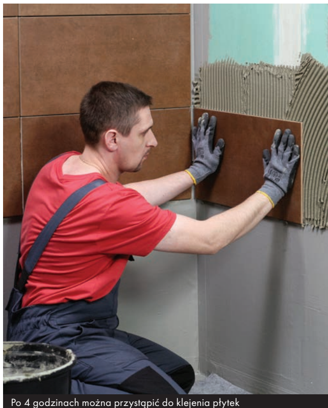
Po 4 godzinach można przystąpić do klejenia płytek
