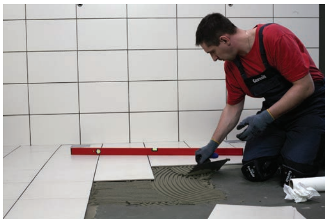
Nawet w przypadku aplikacji pacą zębatą o dużych zębach brak efektu rolowania zaprawy na podłożu. Dodatkowo po każdorazowym przeciągnięciu pacą czynność ta staje się łatwiejsza
