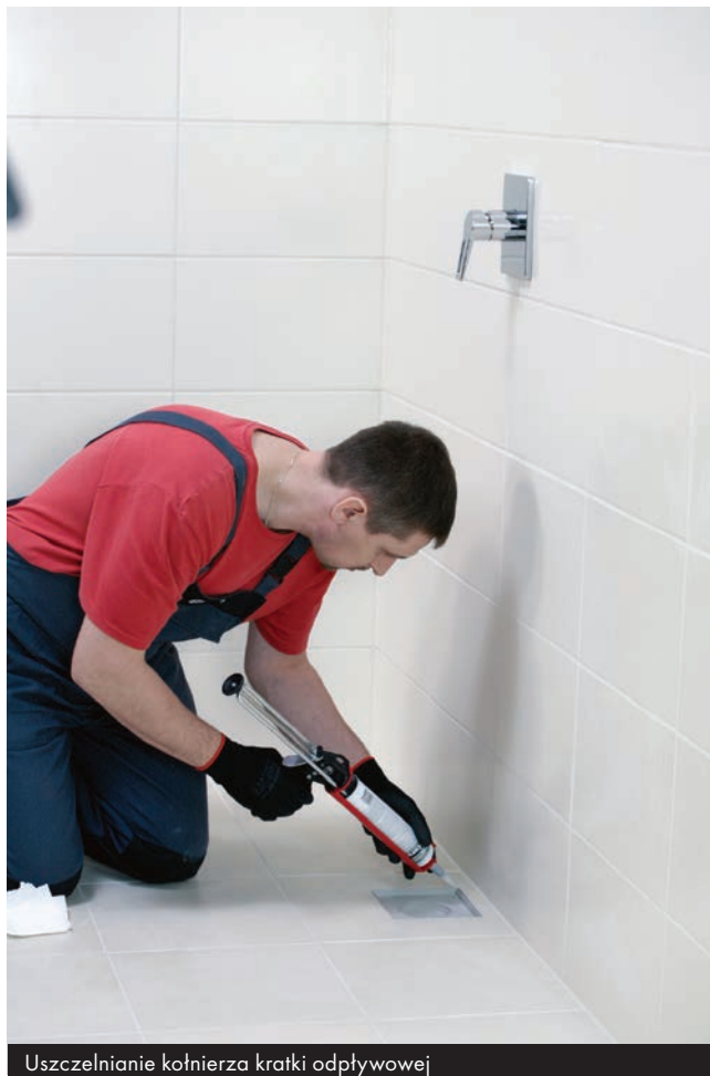
Uszczelnianie kołnierza kratki odpływowej
