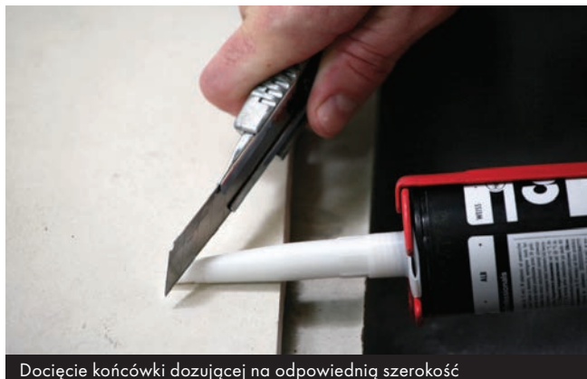
Docięcie końcówki dozującej na odpowiednią szerokość
