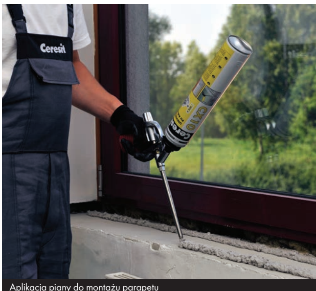
Aplikacja piany do montażu parapetu
