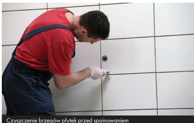
Czyszczenie brzegów płytek przed spoinowaniem
