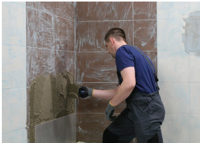
Doskonale nadaje się do klejenia płytek na istniejącej okładzinie ceramicznej
