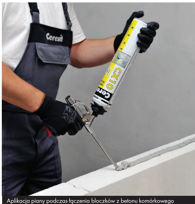
Aplikacja piany podczas łączenia bloczków z betonu komórkowego
