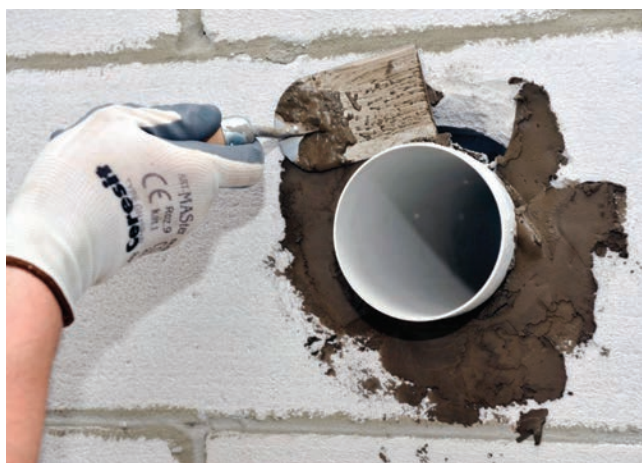
Montaż za pomocą zaprawy CX 5
