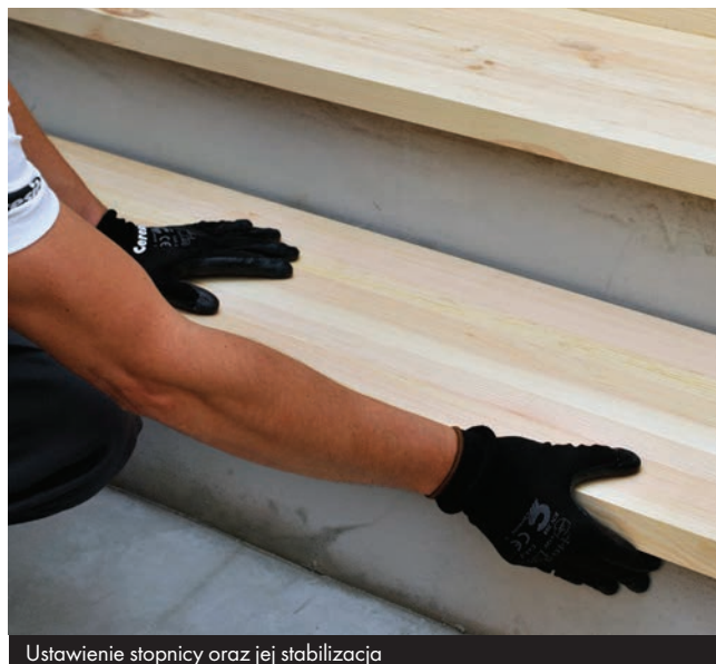
Ustawienie stopnicy oraz jej stabilizacja
