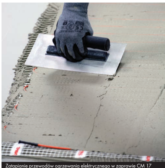
Zatapiać przewody ogrzewania elektrycznego w zaprawie CM 17
