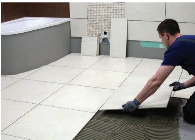
Dzięki zastosowaniu specjalnej kombinacji wypełniaczy zaprawa CM 11 PLUS, doskonale nadaje się do klejenia płytek gresowych
