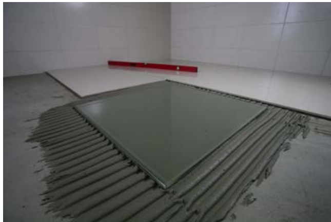
Doskonale parametry robocze pozwalają na uzyskanie 100% rozpiętywu zaprawy CM 22 pod płytką
