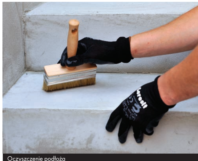
Oczyszczenie podłoża
