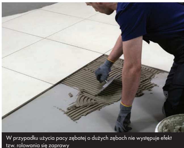
Zaprawa CM 17 umożliwia klejenie płytek wielkoformatowych na powierzchniach z ogrzewaniem podłogowym
