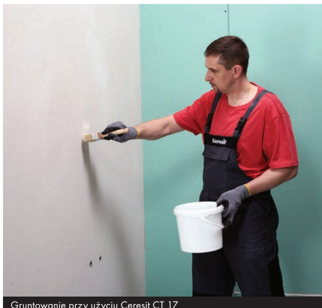
Gruntowanie przy użyciu Ceresit CT 17
